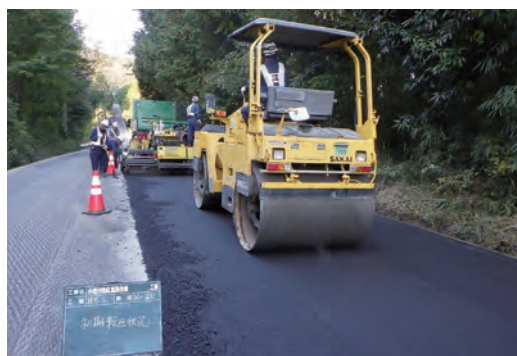
◀アスファルト打設状況
