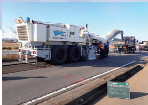
▲既設舗装撤去状況
